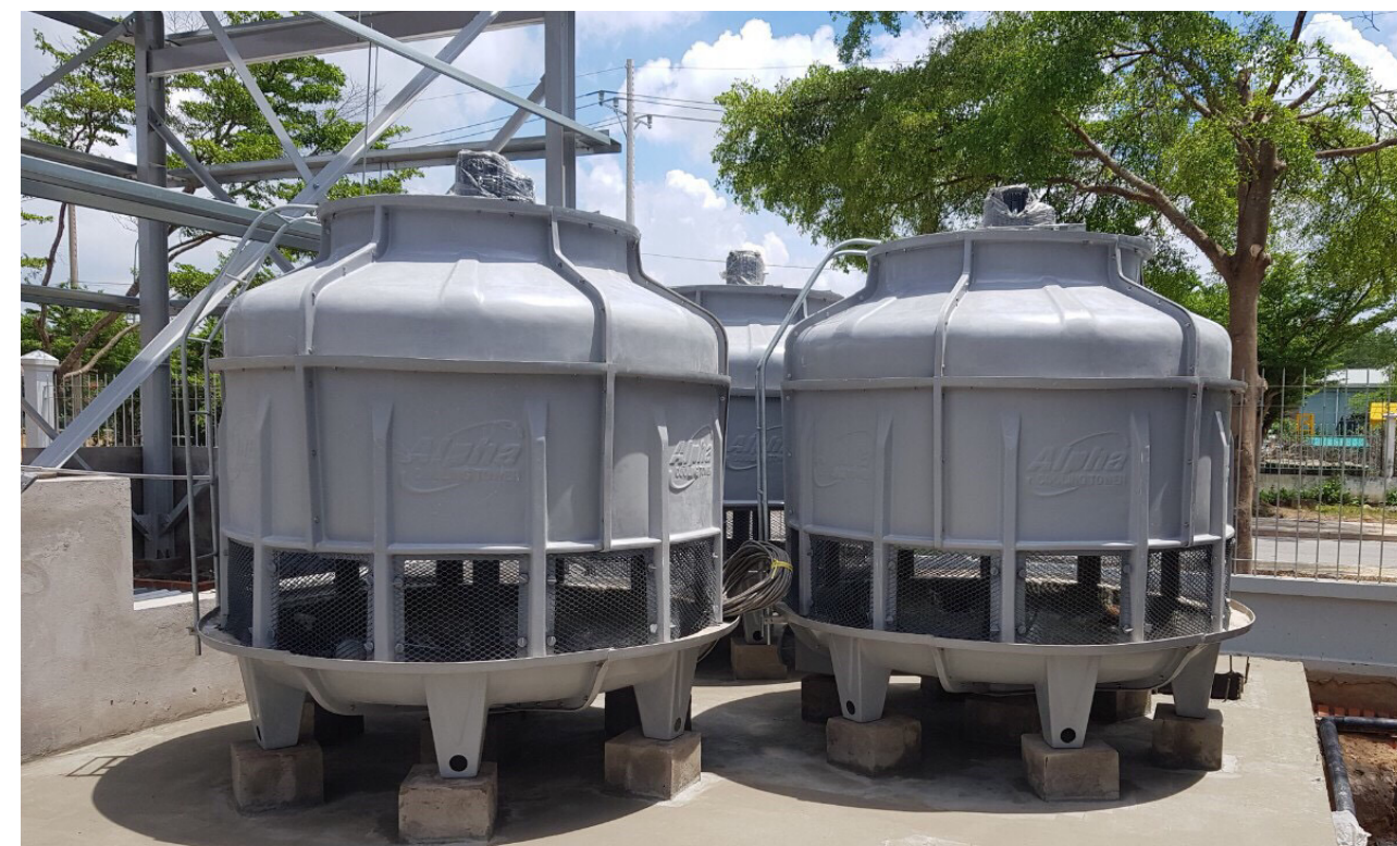
NHÀ MÁY AUSTDOOR NHƠN TRẠCH ĐỒNG NAI
